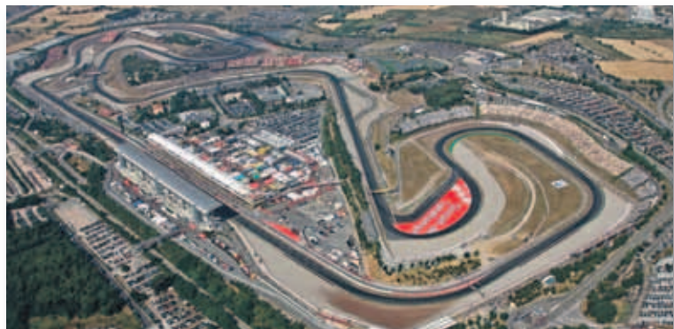
Panorámica del Circuit de Barcelona-Catalunya, en Montmeló
